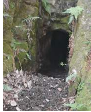
黒谷池側より向かった隧道の出口。岩盤を手掘りして削ったあとがはっきりわかる。作業しやすいためか、出口周りの空間も掘ってあった
