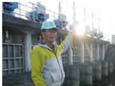
昭和樋門も2006年に電動巻き上げ式のステンレス製フラップゲートに変わった。「昭和17年8月の満潮時に大型台風が来て堤防が決壊して、名田島で32名が亡くなってね。牛馬はもっと」浅原さん（写真）が説明してくれた。家の被害も約300戸、水稲500町歩全滅という大災害だった
