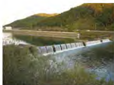
取水は榎野川上流にある淋洗井堰（りんこういせき）から。寛永・万治年間（1640～1660）に築造。川の東側（写真では向こう岸・左岸）に、名田島へ流れる用水路がある。右岸側は小郡を潤す
