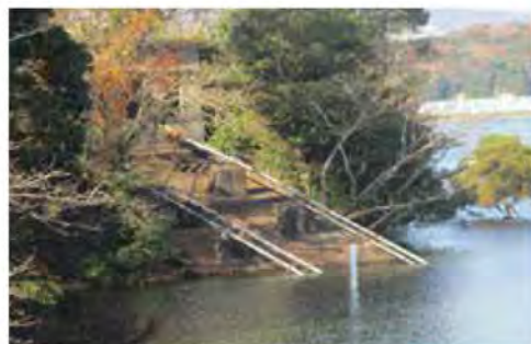
ため池施設:斜樋
