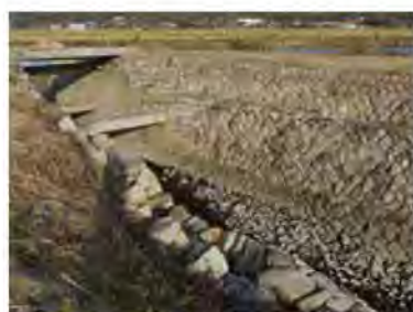
榎野川寄り（西）から堤防を歩き始めると、まず三挺樋があった。古い絵図からかつては榎守小屋もこの堤防の東にあったことがわかっている
