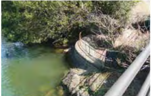
ため池施設:余水吐流入部
