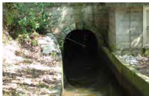
ため池施設:底樋出口
