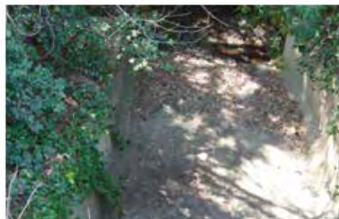
ため池施設:余水吐放流部
