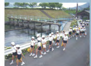
排水路の代わりとしてまちを災害から守ってきた佐波川用水。水路の維持のため、組合員だけでなく、地域住民にも呼びかけて清掃活動を行っています。
