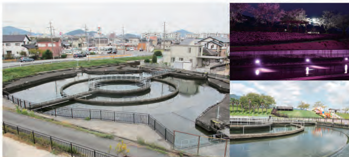
防府総合用水円筒分水工
