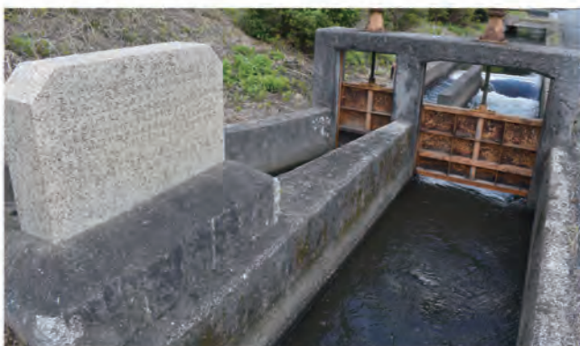
昭和43(1968)年にできた寝太郎用水分水工。石板には分水協定が彫られている。幅の太いほうが、東幹線へと流れていく。現在は西幹線のほうが耕作面積は広いが、全体に耕作地が減ってしまったため、この分水幅のままで足りているのだそうだ
