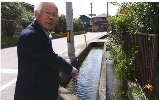
用水路は水系ごとにあり、水系が違う2本の水路が並ぶ場所も。水路の高さもスピードも違う。防府土地改良区の属理事長が説明をしてくれる
